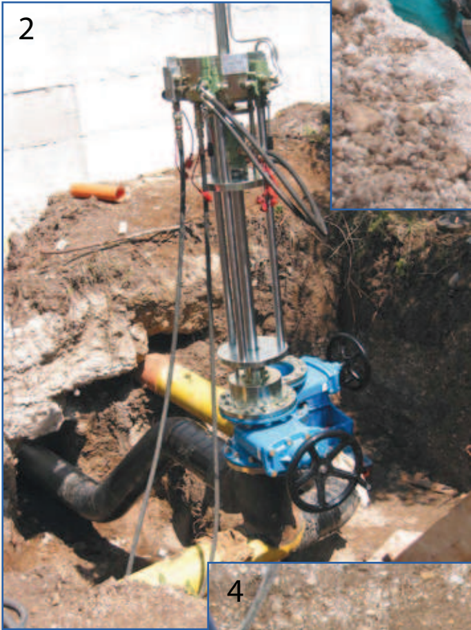
Foto 2 Macchina foratubi idraulica Hydraulic pipe drilling machine
