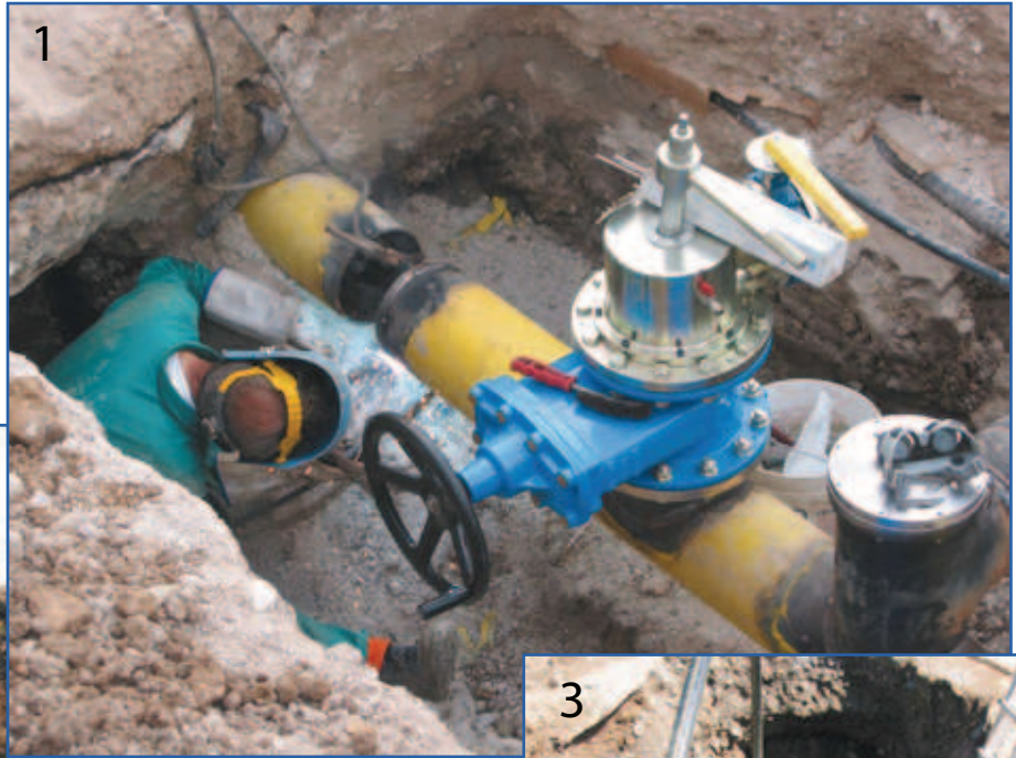
Foto 1 Tubo intercettato e saldatura fondello Interception and plug welder
